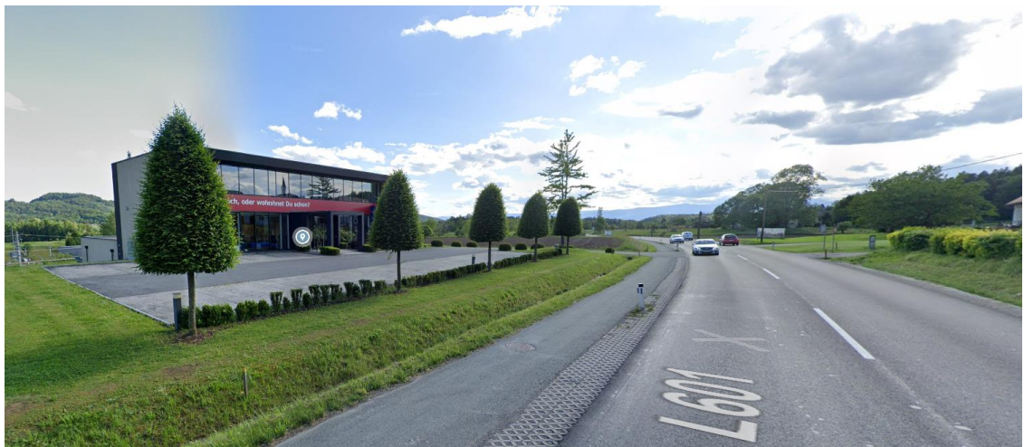
Bestehender bzw. Planungsbereich | Google-Maps
