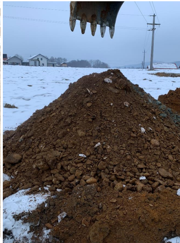
Foto 8: Schurf S4, Aushub Kies
